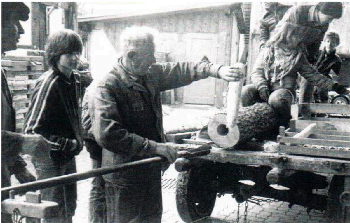
Nun kamen die Arbeiter zurück und arbeiteten weiter, sie mussten jetzt noch Späne im Stamm entfernen. Als sie bohrten, konnte ich auch am alten Tüchelbohrer drehen helfen. Immer, wenn wir den Bohrer herauszogen, hatte es grosse Späne im Löffel. Nach etwa eineinhalb Stunden war der Stamm fertig gebohrt. Das fertiggestellte Loch musste noch mit einem Jutesack poliert werden.
