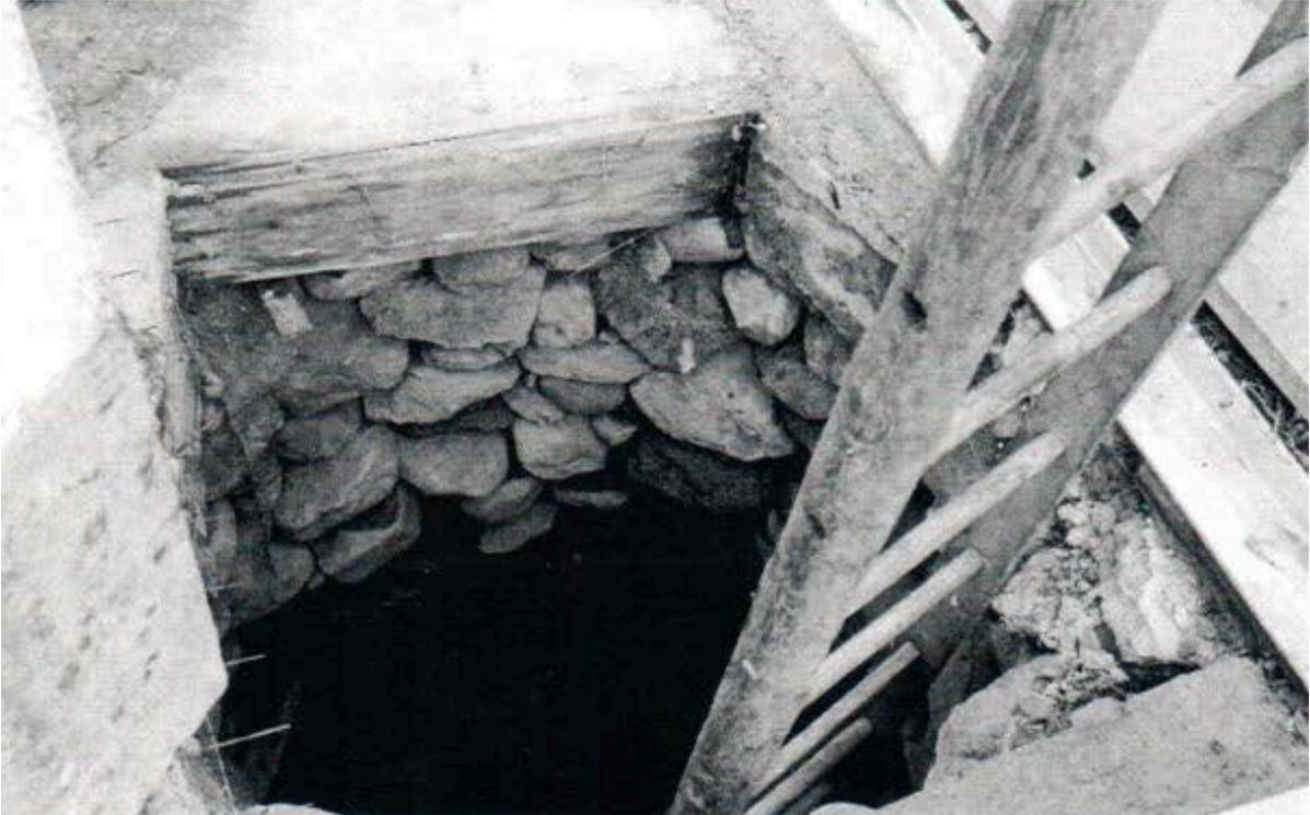
Mit vereinten Kräften - die Söhne des Hans Freitag helfen wacker mit - wird der neue Tüchel auf den alten, der im Grundwasser steht, aufgesetzt und nachher abdichtet.
