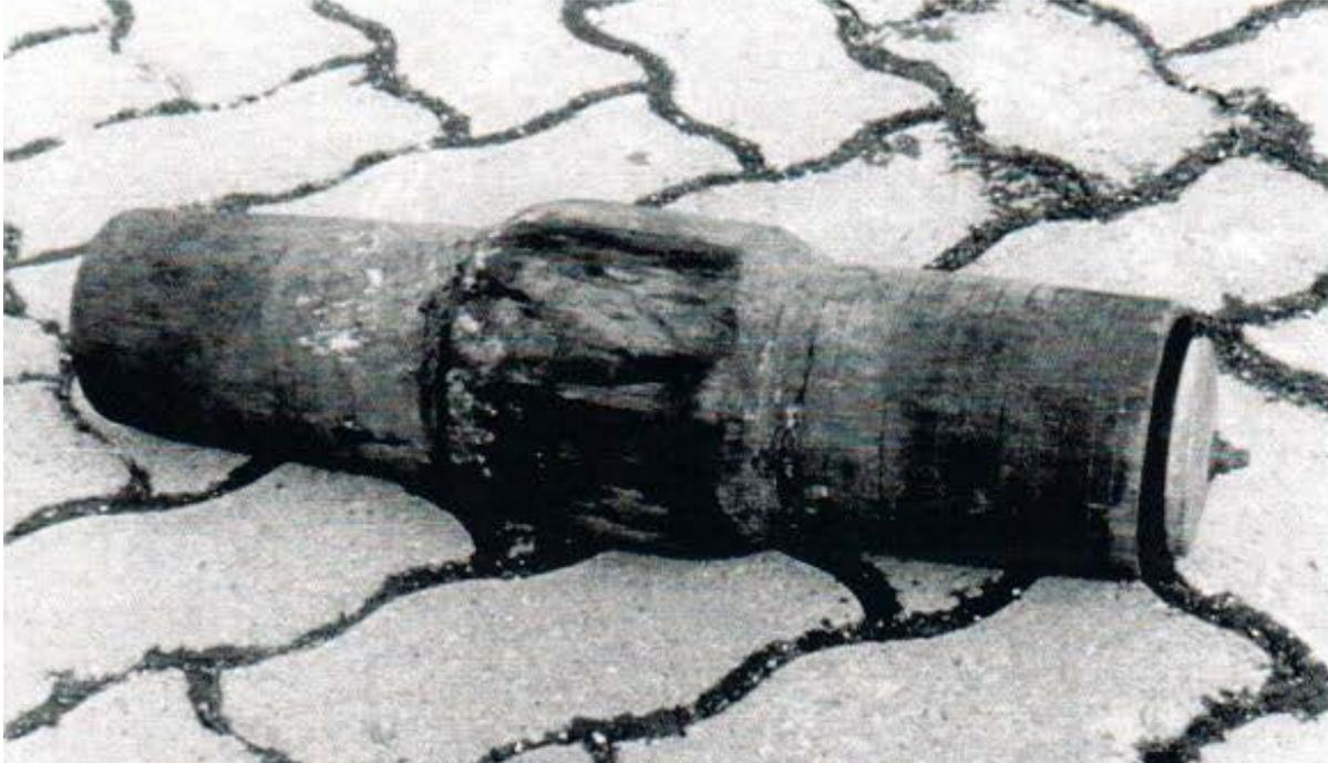
Das Verbindungsstück ist im neuen Tüchel montiert und verkittet. Mit einem "Kännchen", aus Eichenholz und Rindsleder gefertigt, wird dann durch Vakuum das Wasser vom Ventil zur Brunnenröhre gepumpt.
