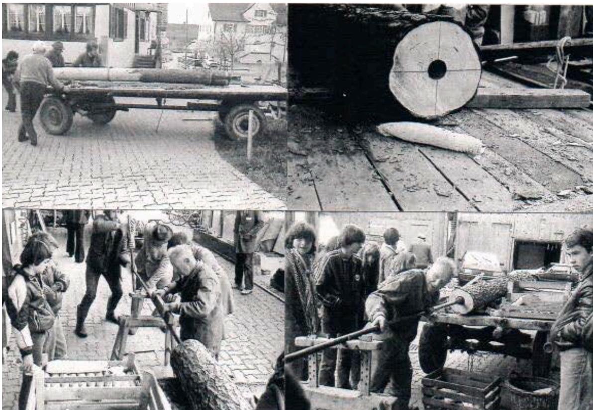
Das alte, steinharte, eichene Verbindungsstück der beiden Tüchelstämme und die Ventilklappe (am rechten Ende sichtbar) können wiederverwendet werden.
